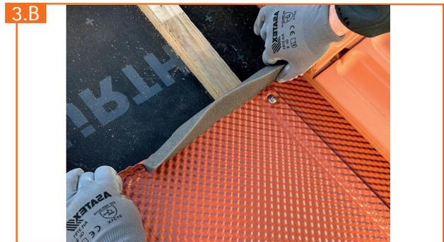
3.B Äußere Ende der Pfanne einklappen und Umlegefalz mit aufgeklebtem Kehldichtstreifen aufklappen
