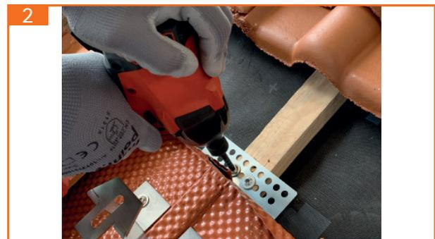
2. geba PV flex mit zwei Sparrenschrauben befestigen.
