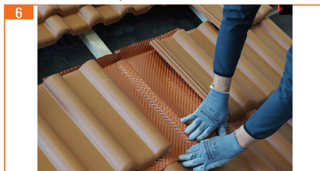
6. geba PV flex an Kontur des Ziegels mittig beginnend nach außen anformen und fest andrücken.
