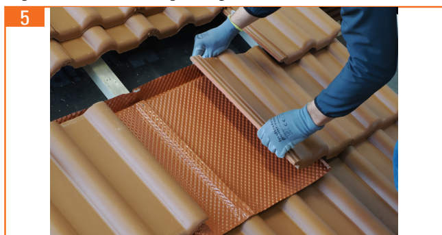
5. geba PV flex andere Seite eindecken.
