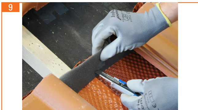
9. Kehldichtstreifen an Dachhakenposition L-förmig einschneiden.
