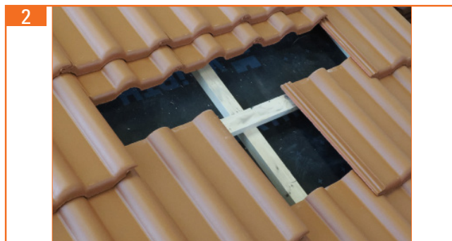
2. Originaldachziegel entnehmen
