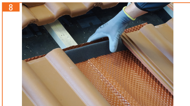
8. Schutzfolie des Kehldichtstreifens (500 mm) abziehen und bündig zur oberen Kante anbringen.
