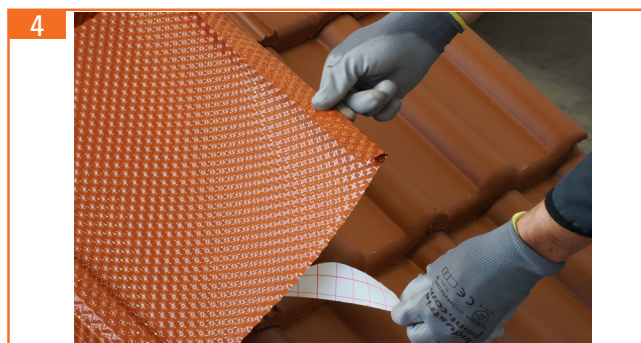
4. Schutzfolie des Butylklebestreifens abziehen.
