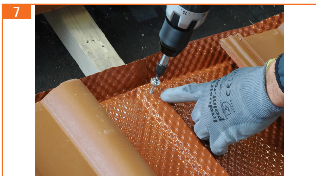
7. mit Spenglerdichtschraube (4 x 30 mm, TX 20) fixieren) - bei Bedarf -
