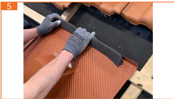
5. Schutzfolie des Kehldichtstreifens (500 mm) abziehen und auf der oberen Kante anbringen
