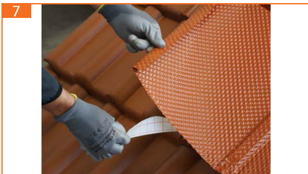
7. Schutzfolie des Butylklebestreifens abziehen
