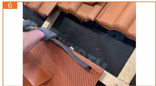
6. Obere Aluminiumaufkantung nach vorne einschlagen
